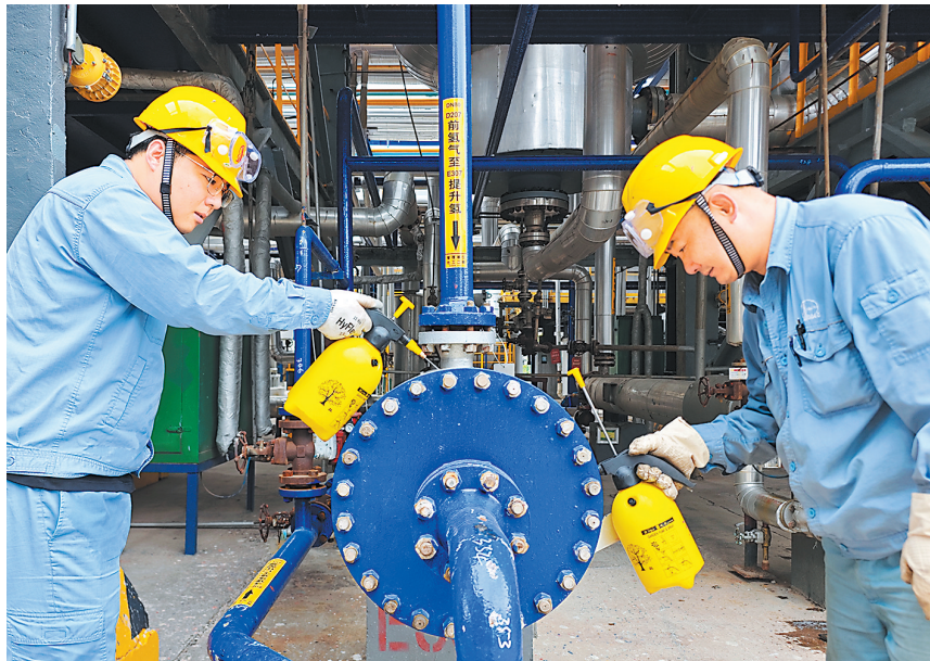
6月5日,金陵石化1号连续重整装置顺利开工。开工前,工作人员严格对照开工方案进行安全条件确认,加强塔顶等部位排查,为安全环保开工做好准备。图为化工二部员工细致开展开工前气密性检查。王恒摄 陈伟文
