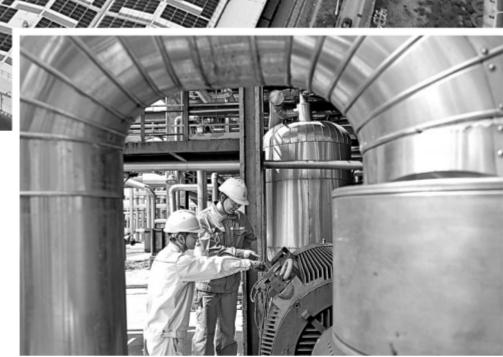
近日,扬子石化组织数字化技术团队,运用流程模拟技术,优化顺丁装置丁二烯回收系统运行参数,使再沸器能耗降低超20%,实现运行成本显著下降。图为5月29日顺丁装置操作人员对回收系统热水泵振动情况进行检查。
