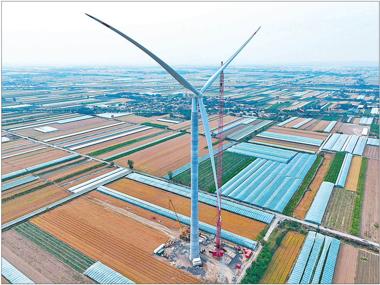
中国石化首个混塔结构风电项目首台风机吊装
