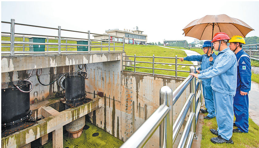
九江石化提前筹备防汛物资,做好人员调配安排,对码头、罐区等重点区域开展全面排查,疏通排水系统,确保防汛工作万无一失。图为5月28日员工检查两台新增排涝泵情况。赵石城 摄
