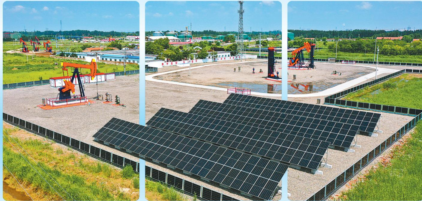
胜利油田现河采油厂郝现采油管理区采用“光伏围栏+直流母线群控”多源供电技术，实现用电峰值时的直接利用和余电反馈上网、多井自动错峰运行。
