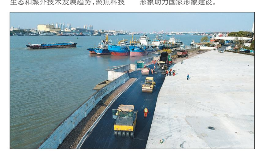
12月14日,在高桥石化新建停车场,具有透水性能的200米沥青路面铺设完成,标志着中国石化透水沥青环保新技术成功应用。新技术由炼油销售和高等院校联合研发,将废旧轮胎胶粉与特定材料结合,进行处理后制成沥青改性剂,将高桥石化生产的优质沥青进行改性后,沥青黏度进一步提高,适用于透水路面,实现绿色循环利用。图为12月14日施工人员铺设透水沥青路面。
