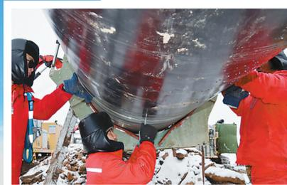
员工仔细测量核对,将管道对准、合并。之后,加热、焊接作业才能有序开展。
