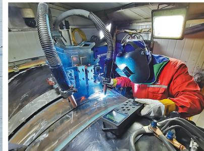
焊工正在焊棚里进行全自动焊接作业。
