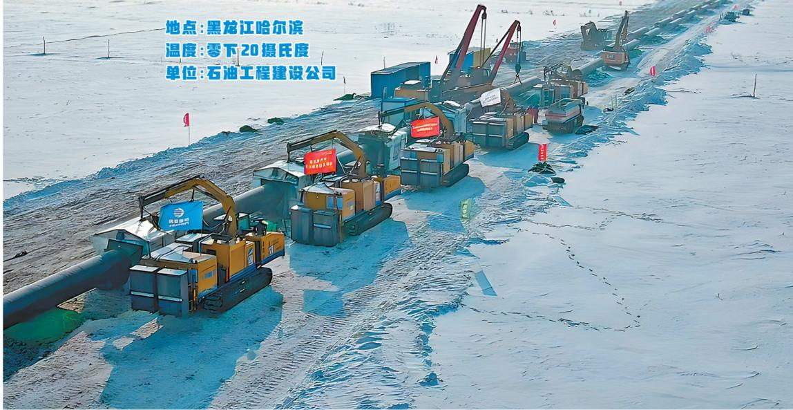
在茫茫东北雪原,石油工程建设公司承建的虎林—长春天然气管道工程二标段现场,全自动焊接机组火热施工中。
