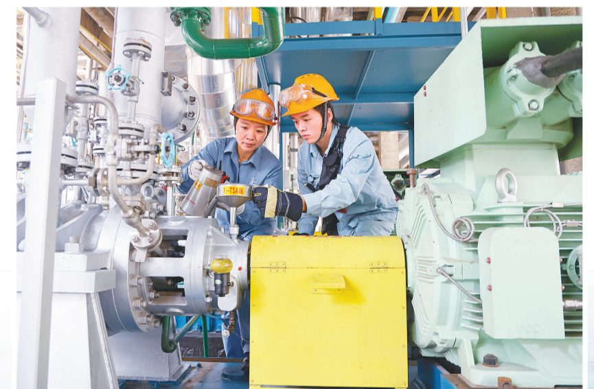
镇海炼化重油催化装置外操正在进行机泵的常规维护工作。
