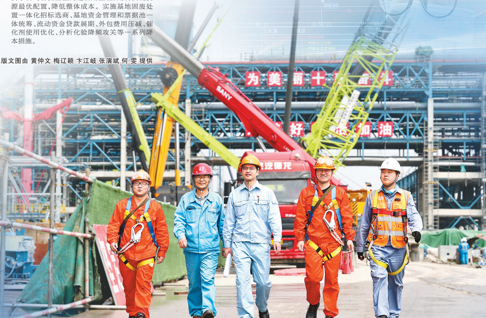
镇海基地工程建设现场的“工程人”。
