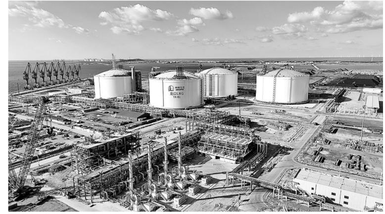
10月30日，十建公司承建的中国石化龙口LNG项目4座22万立方米储罐实现高标准机械完工。投用后，将持续稳定为山东、环渤海区域，以及华北地区输送液化天然气。图为该项目储罐现场。
