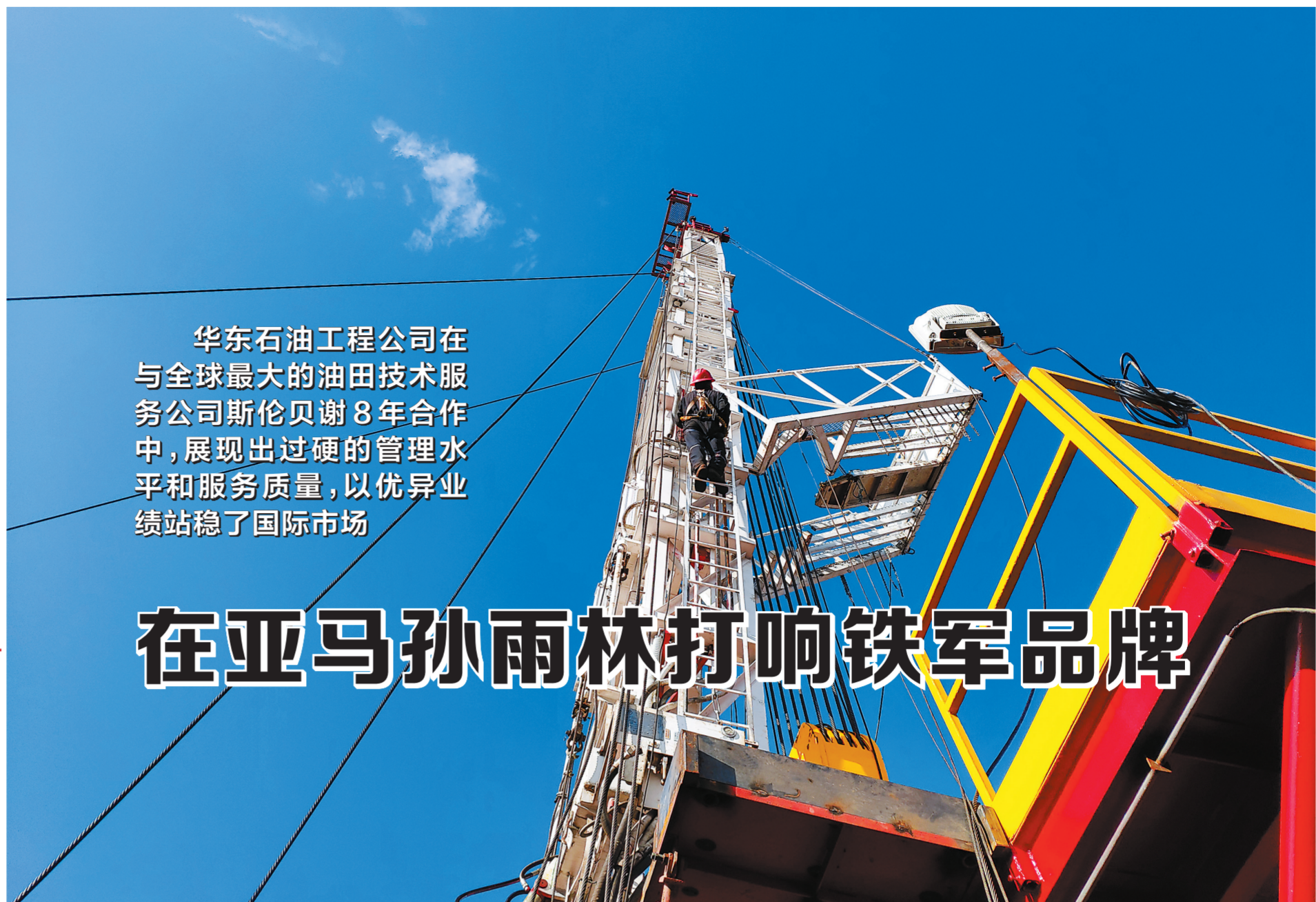
修井队作业现场。
