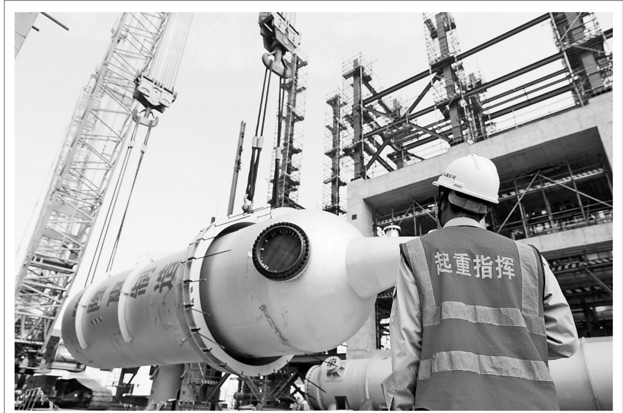
湖南石化重点项目大件设备顺利吊装
