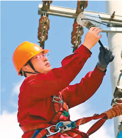
马广俊登杆调试配电线路运行监控配套装置。
