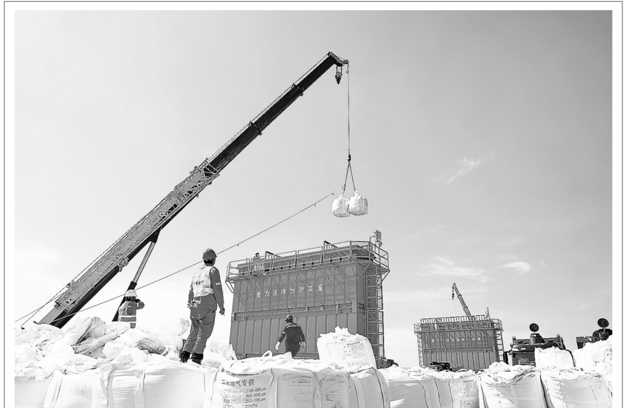
华北油气加快实施煤层气重点工程 华北油气分公司全力推动深层煤层气资源战略接替,成立工作专班,开展科技攻关,强化优质煤层和微构造精细刻画,加快实施煤层气重点工程,今年以来,4口煤层气井完钻,其中3口井完成压裂。图为日前大牛地气田煤层气勘探水平井DNSP2井压裂现场。 李昕 摄
