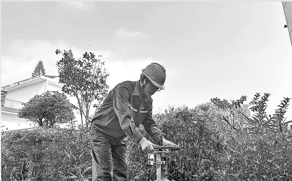
日前,广东石油寮步油库员工对无线远程手动阀门状态采集系统进行调试。 连宗凯 摄
