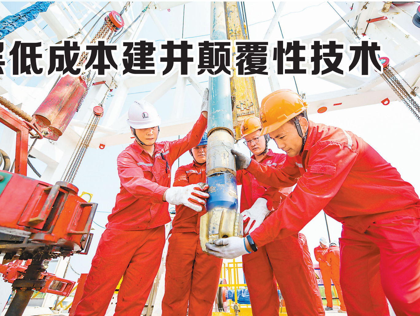
胜利石油工程渤海钻井40619队进行全过程套管钻井施工。
