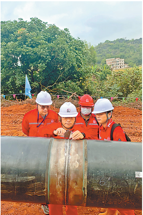
茂名-云安项目质检人员对焊缝质量进行检测。
