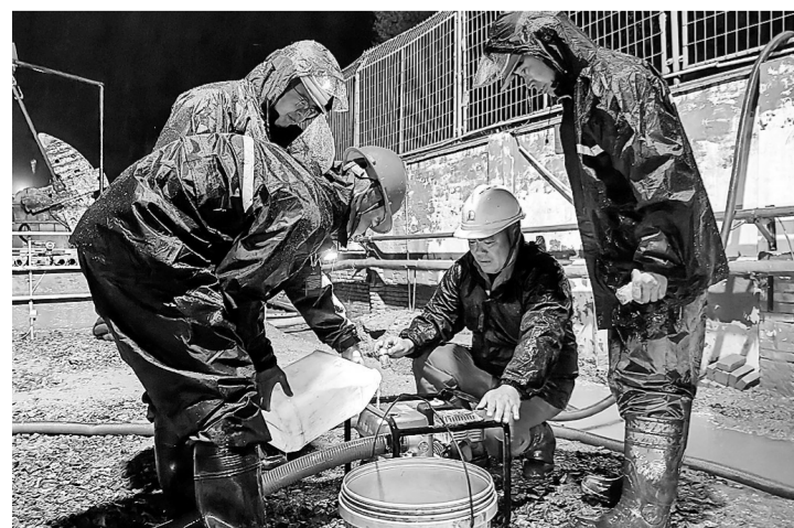
图为降雨减弱后,党员突击队员在现场为抽水泵补给燃料,及时清除井站内积水,保障现场生产安稳运行。郭澜涛 摄
