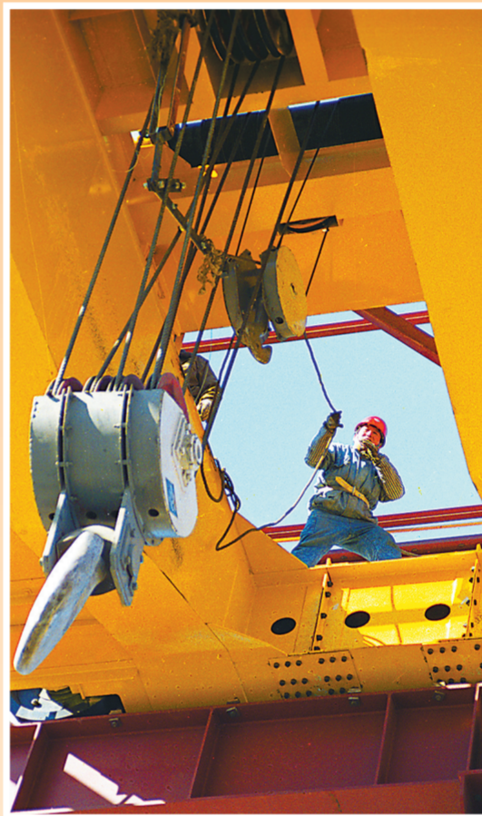
▲十建公司老一代起重吊装在齐鲁乙烯项目施工现场指挥乙烯火炬吊装。 邹度龙 摄
