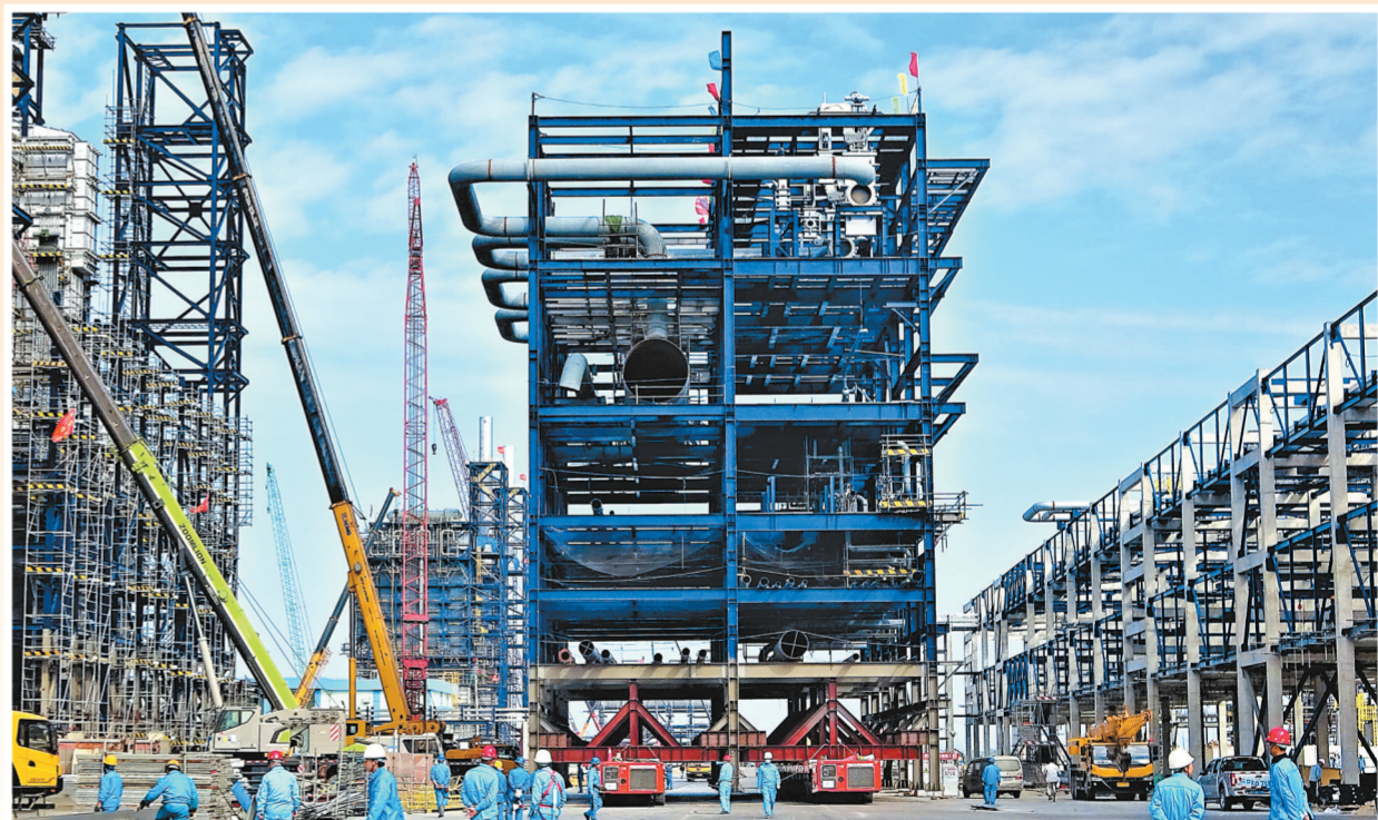
十建公司员工在古雷石化乙烯项目进行钢结构模块化施工。
