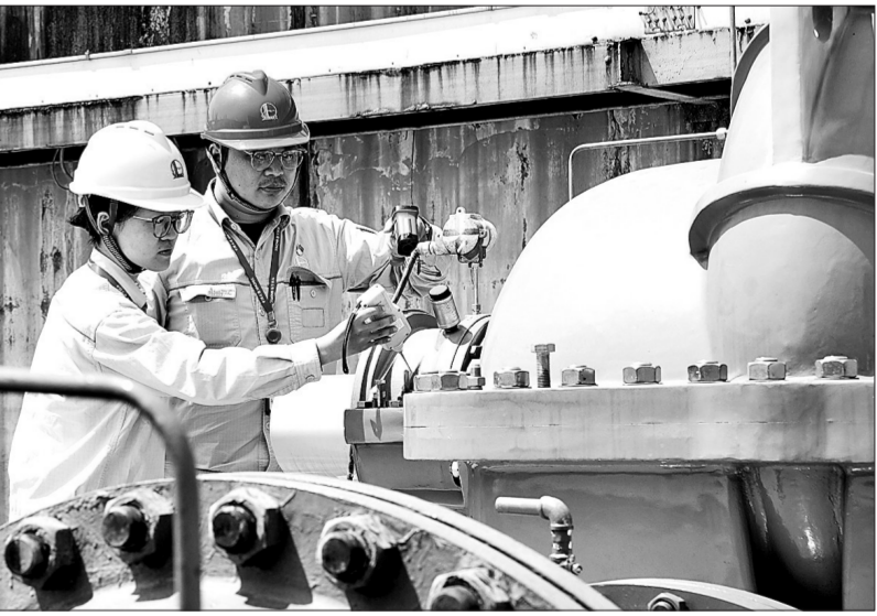
近日,扬子石化水厂炼油水务车间机泵更新完毕,这一公司绿色节能重点项目开始运行。该项目通过更换6台循环水高效节能泵、新增2台管道增压泵,大幅降低系统能耗,预计每年节约电费超300万元。图为8月8日技术人员检测节能泵运行状态。 门圣卿 摄 陶炎文
