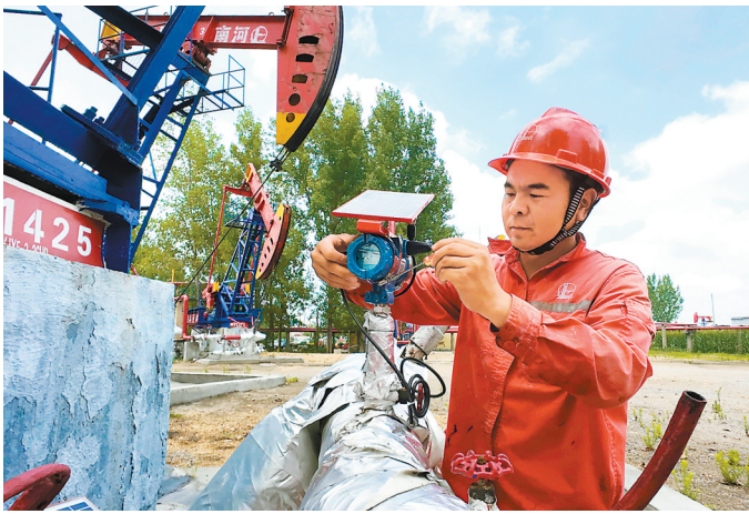
河南油田着力推动绿色发展,推进新能源装置在油井生产现场应用。今年上半年,完成520套光伏逆变器安装任务。图为井楼油区员工在楼31425井安装自主研制的光伏逆变器。
