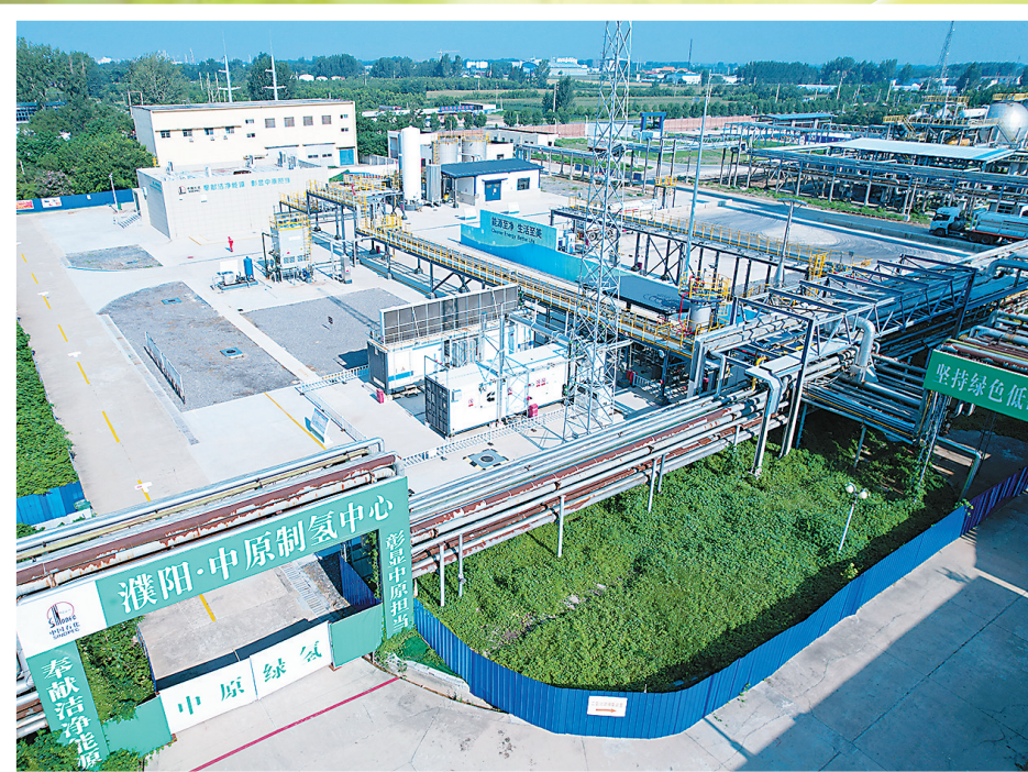
中国石化兆瓦级可再生能源电力电解水制氢示范项目俯瞰图 赵奕松 杨岭敏 摄影报道
