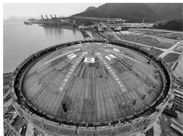
6月27日,四建公司承建的中国海洋石油浙江LNG三期项目1号储罐穹顶与承压环对接成功,完成气顶升工作。此次气顶升重量达1103吨,气顶升工作存在体积大、吨位大等难点,工程项目部周密指挥、紧密协调,确保过程工序安全衔接、作业人员高效沟通。图为1号储罐气顶升作业现场。李中伟 摄 曲照贵 文
