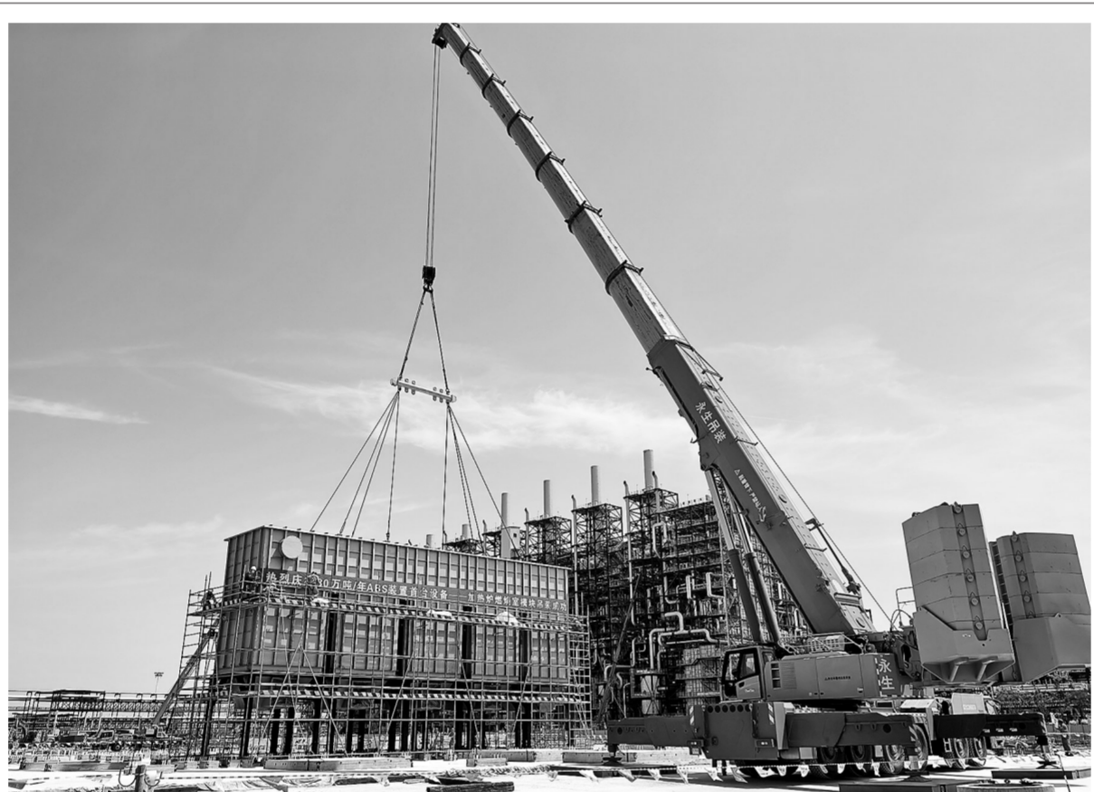
天津南港乙烯ABS项目首台大型设备吊装就位
