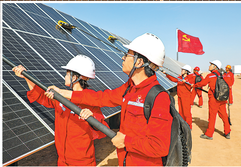
西北油田工程服务中心电力工程管理部员工在清洁光伏板。
