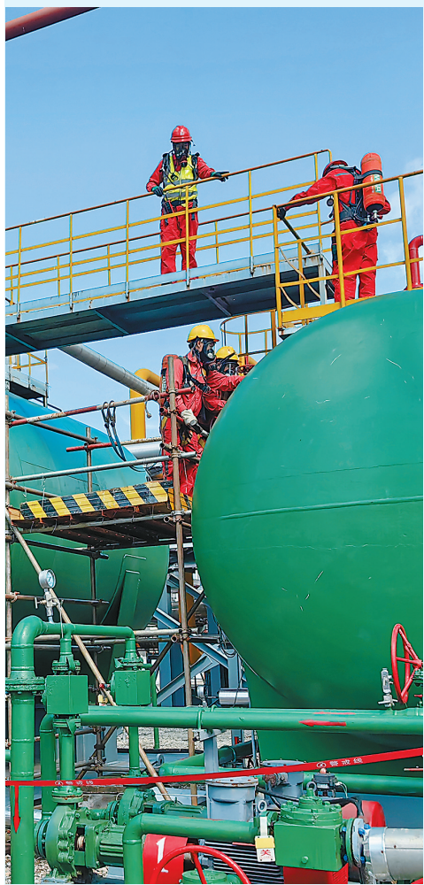
普光气田员工在更换污水缓冲罐液位变送器接线箱。
