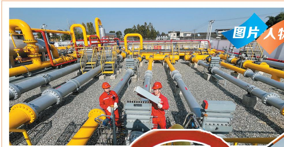
输配气站员工在进行高级孔板阀清洗。
