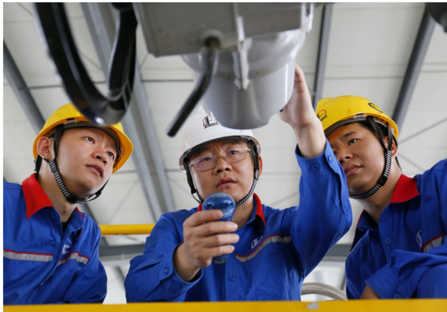
浙江杭州石油桐庐油库工作人员调试管输末站输油电动阀,确保电动阀开关定位准确。
