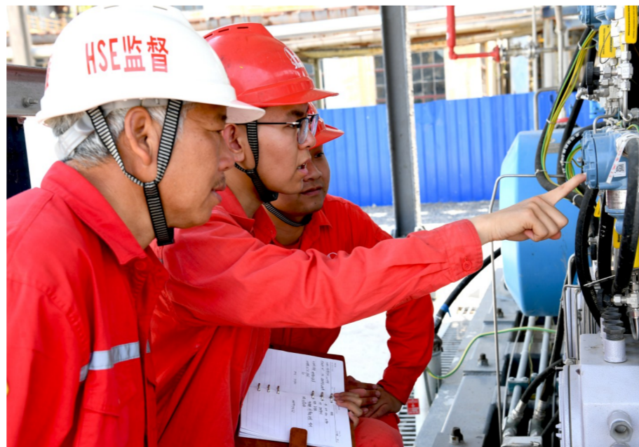
中原油田设备管理人员联合安全管理人员重点检查设备控制线路。
