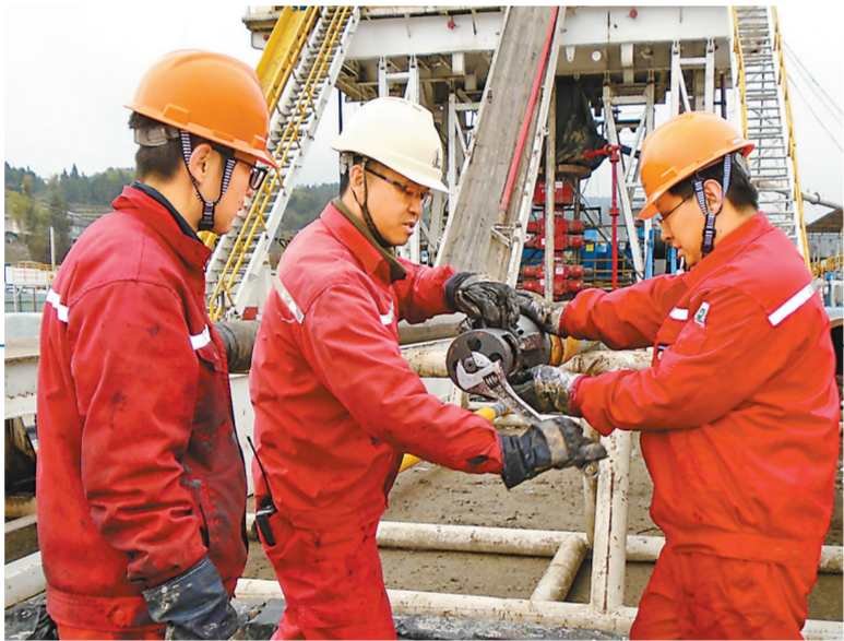
▲施工人员将岩芯从套管内取出。宁仁磊摄
