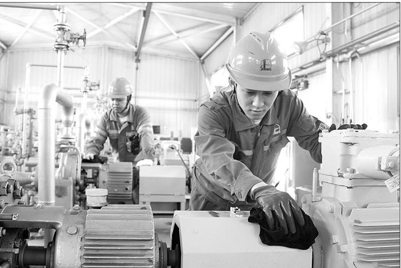
为推动安全管理提升年行动,塔河炼化储运作业部依据现场“5S”管理标准,通过统一罐区标识、泵房标准化建设、加强机泵卫生管理等,助力现场标准化建设。同时,要求班组每天对机泵、阀门、仪表等设备进行检查,确保其完好备用。图为5月13日班组人员擦拭机泵。朱军丽 摄
