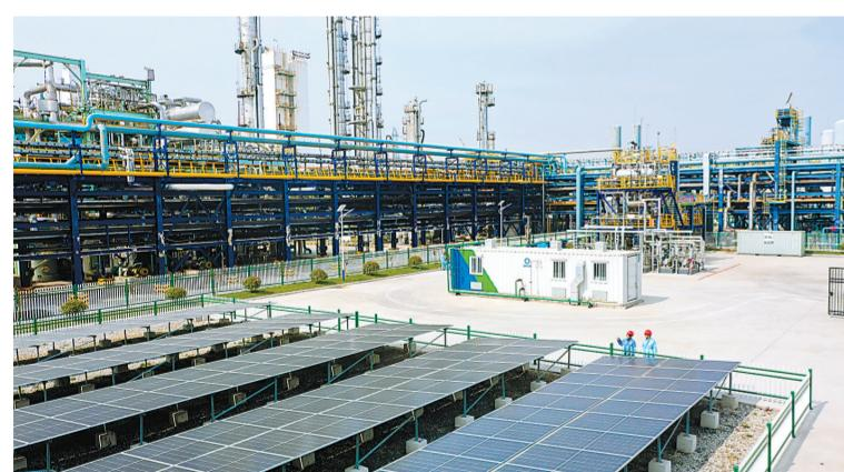
▲南化公司百吨级绿色甲醇中试装置,采用光伏发电、电解水制氢、二氧化碳加氢制绿色甲醇工艺,日平均发电量1154千瓦时,转化率等指标居国内领先水平。图为装置现场。
