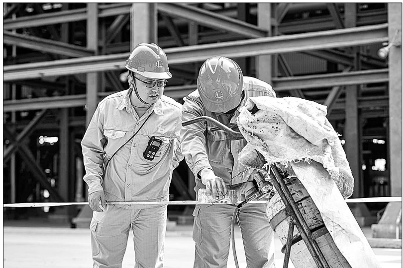
海南炼化2号连续重整轻重组分分离项目建设以来,作业人员战高温,24小时轮班施工,奋力推进项目建设。采取布置遮阳伞、调整作业时间等措施,做好防中暑工作。目前,现场施工进入管道试压阶段,为高质量中交奠定基础。图为4月29日HSE部人员检查乙炔气瓶和管带连接情况。
