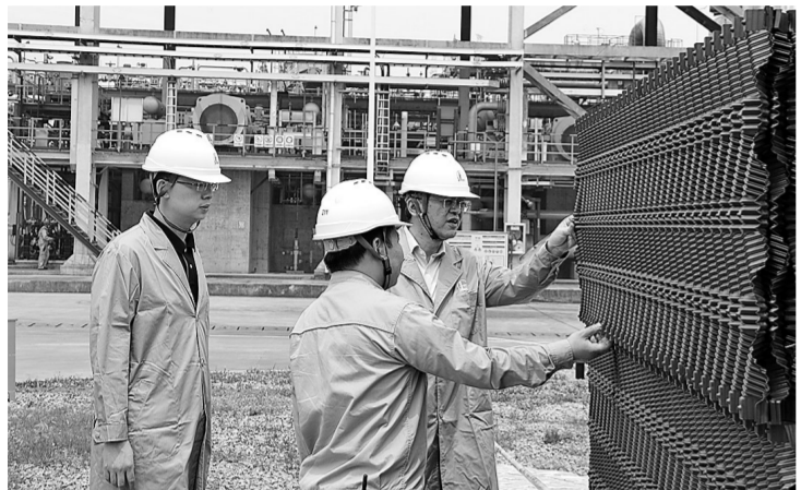
团队成员在氮气提纯升级改造项目施工现场检查装置填料质量。陈伟摄
