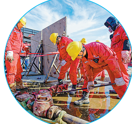
塔河油田TP1110新井进行酸化压裂施工作业。 石立斌 于腾飞 摄影报道
