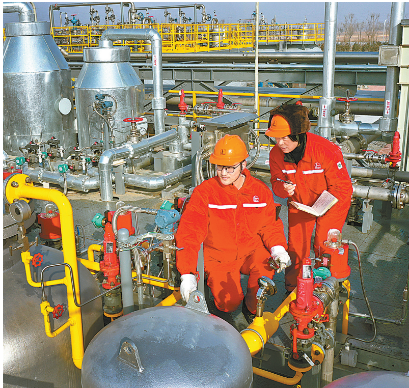
胜利油田东辛采油厂节日期间有序推进某113CCUS项目集中处理站建设,项目设计年处理流量达35万吨,建成后可实现采出液全程密闭处理。图为2月10日大年初一技术人员巡检处理站关键站。 朱克民 摄 张胜利 文
