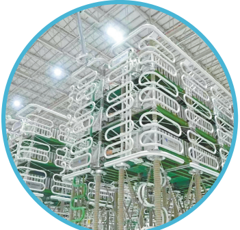
南方电网应用超纯净聚丙烯膜料生产的电容器。
