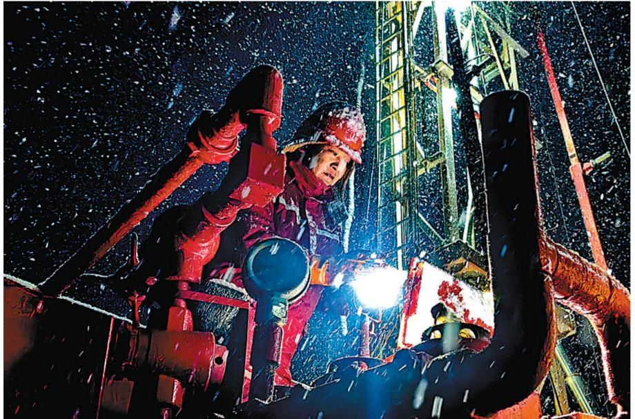
1月18日,河南油田百里油区大雪纷飞,油服中心以雪为令,战风雪、斗严寒。45个维修作业班组,数百名维修队员、测试队员,62台特种作业车辆,奋战在油水井旁,全力保障油水井正常生产。图为油服中心员工在双4-907井进行验套找漏作业。 唐勇 摄韩利娟文
