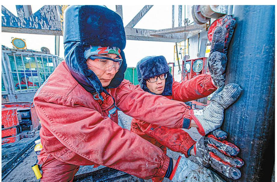
西北油田采油三厂全力保障TKK3-2-4H天然气新井产能建设,做好今冬明春天天然气保供工作。图为员工进行起下钻井管柱作业。 石立斌 摄
