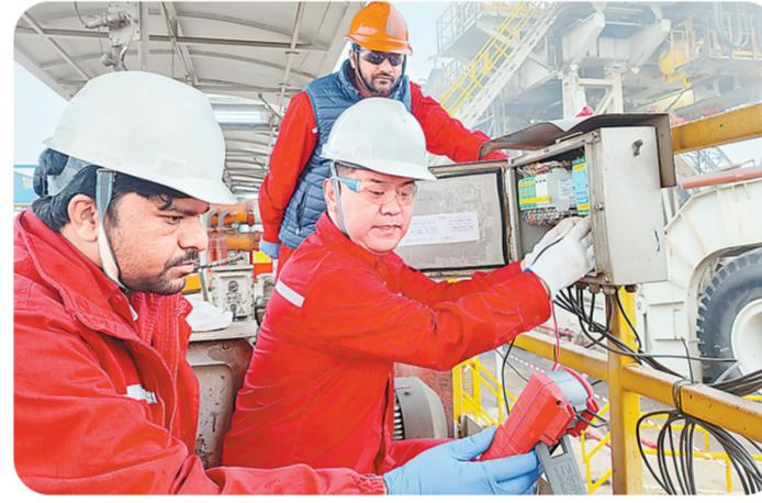
图为李忠仓(中)与外籍员工在循环罐总线箱前检查系冲传感器工作电压。
