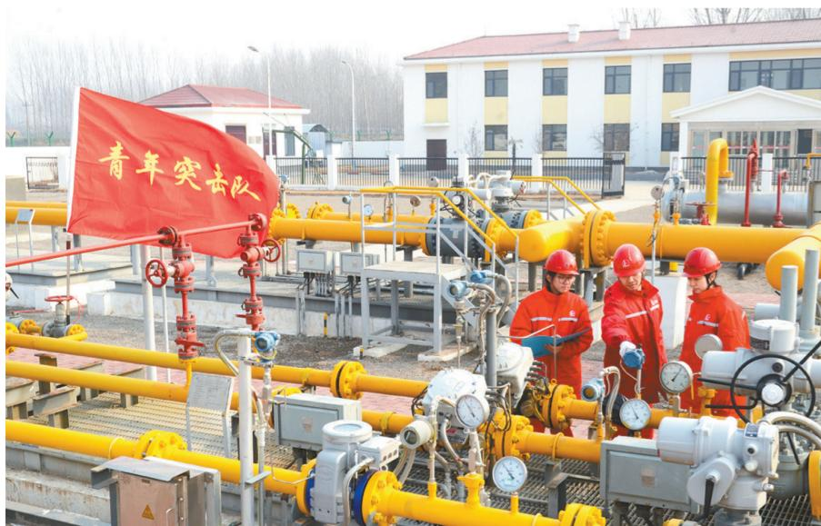
连日来,天然气榆济管道分公司认真落实“百日安全无事故”行动部署,强化装置设备冬季运行管理,加大输气场站阀门、计量和调压等重点装置巡检力度,扎实做好防冻防凝等工作,确保冬季生产运行安全平稳。图为巡检员工检查仪表设施运行情况。
