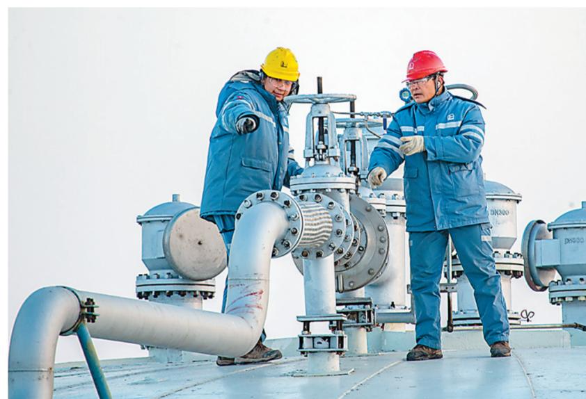
▲连日来,胜利油田河口采油厂飞雁滩油区气温低至零下15摄氏度。采油管理一区注采104站员工加密巡检,保证油井干线回压正常。同时,他们密切关注冰凌对油水井管线造成的剐蹭伤害,保证滩海油田安全清洁生产。图为1月8日,员工紧固油井盘根,排查原油生产压力。
