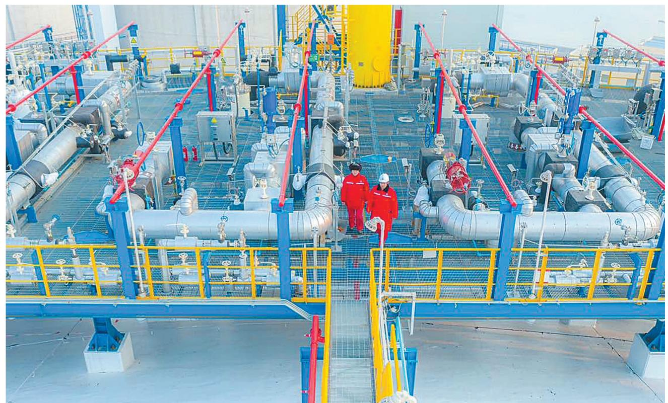
天然气分公司青岛LNG接收站生产运行部成立冬季保供专项工作小组,持续开展工艺流程优化,克服寒潮天气带来的不利影响,做好国内首台27万立方米LNG储罐运行工作,全力保障安稳供气。图为1月8日,员工在27万立方米LNG储罐罐顶巡检。
