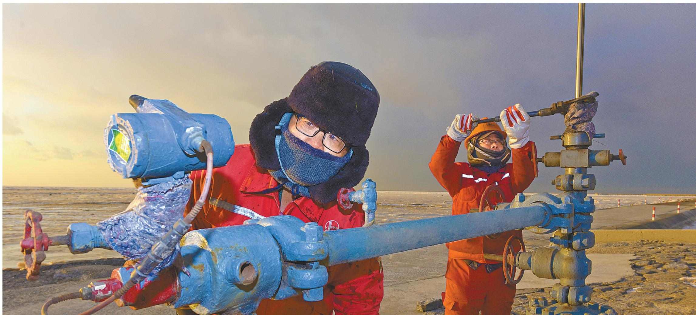
为保障严寒天气站库运行安全,新疆石油全面开展设备设施维护保养工作,实时关注储罐温度,沟通协调承运商车辆合理调配资源,做好油品保供。图为1月8日,伊犁石油伊宁油库员工在检查储罐区紧急切断阀运行状况。
