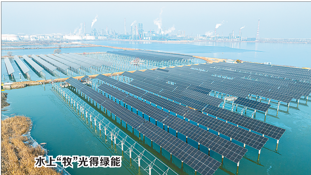
今年以来,青岛炼化应急水池5.48兆瓦光伏发电项目建设持续加快,截至1月12日,已完成施工总量的80%。该项目是青岛炼化首个水上光伏发电项目,利用公司两处闲置应急水池建设,水面开阔没有遮挡物,阳光利用充分进而提升发电量。图为项目施工现场。
