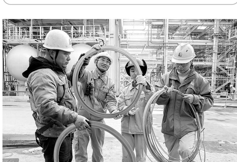
近日,扬子石化炼油结构调整项目开展全员查隐患活动。在新建硫回收装置“三查四定”检查中,该装置重点抓好法兰防泄漏排查,安排专人对法兰垫片逐个摸排,从源头把好密封关。图为1月2日该装置员工对垫片进行对比把关。
