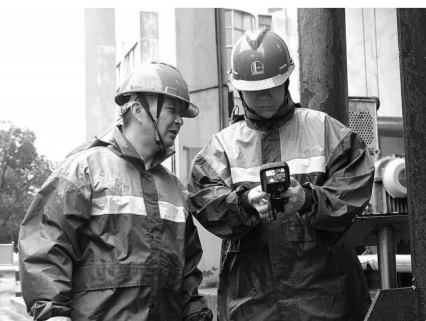
寒潮来袭,为保障各生产装置平稳过冬,上海石化热电部加大防冻保温工作的巡检力度,检查各设备及各个排水口,对破损、老化的设备进行闭环整改。图为员工记录巡检设备情况。
