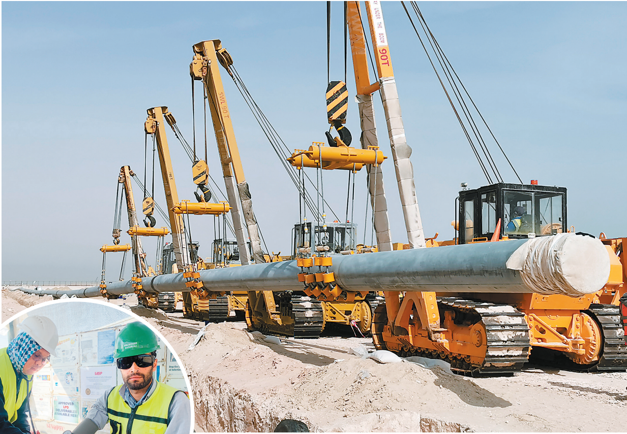
▲图为沙特 MIP PKG16 项目现场管线吊装下沟。
