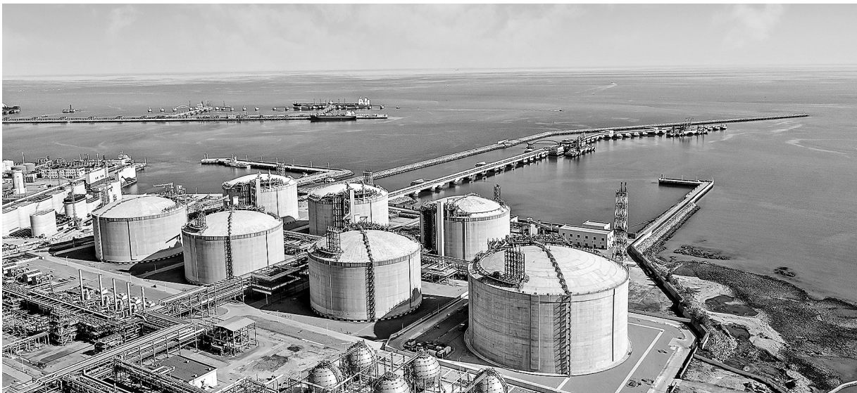
图为青岛LNG接收站一角,最右侧的罐为我国首座27万立方米LNG储罐“胖三”,其余6个罐为16万立方米LNG储罐。 王桂根 摄
