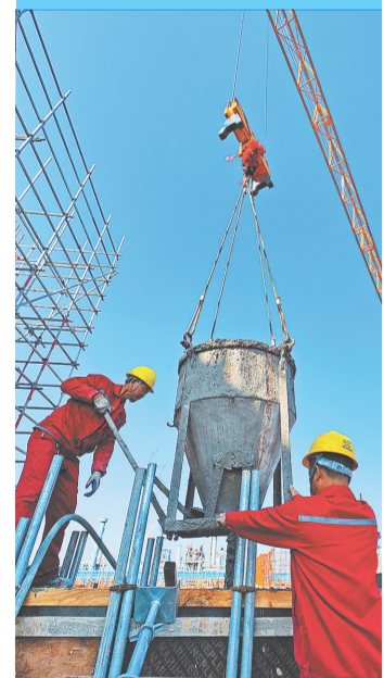
中国石化首个年产50万吨新一代瓶片改造项目土建主体结构在仪式化封顶。刘玉福摄
