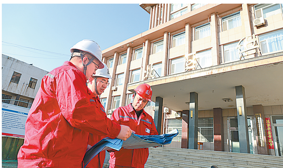
胜利油田新能源开发中心技术人员在研究北苑供电公司办公楼浅层地热能项目施工现场。
