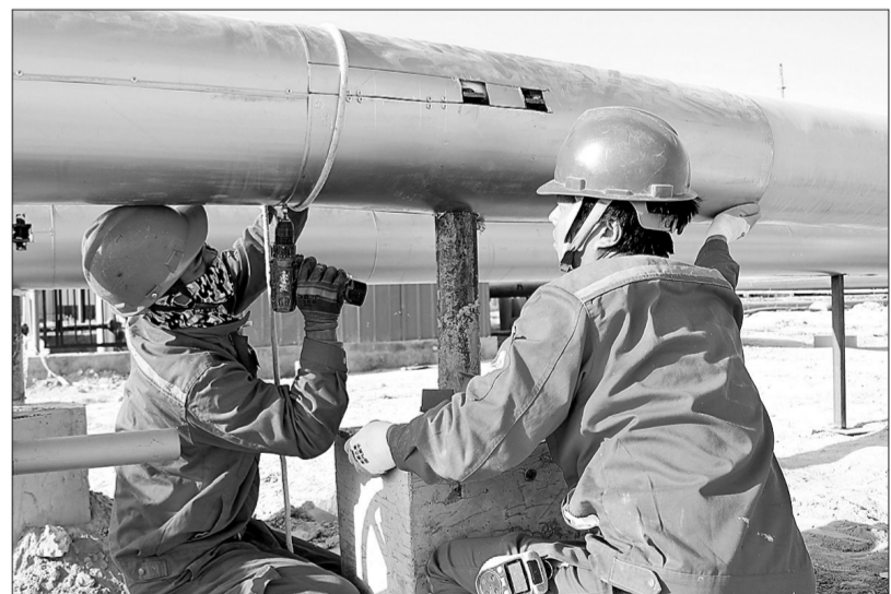
为保障冬季原油生产平稳,西北油田采油二厂采油管理一区开展冬防保温工作。实施提高热效率专项治理,为油气水管网加热装置进行维保;排查整改冬防隐患,为设备管线穿上“防寒服”,目前81处隐患得到消除。图为10月27日员工为12-4计转站外管线进行铁皮保温。张明江摄
