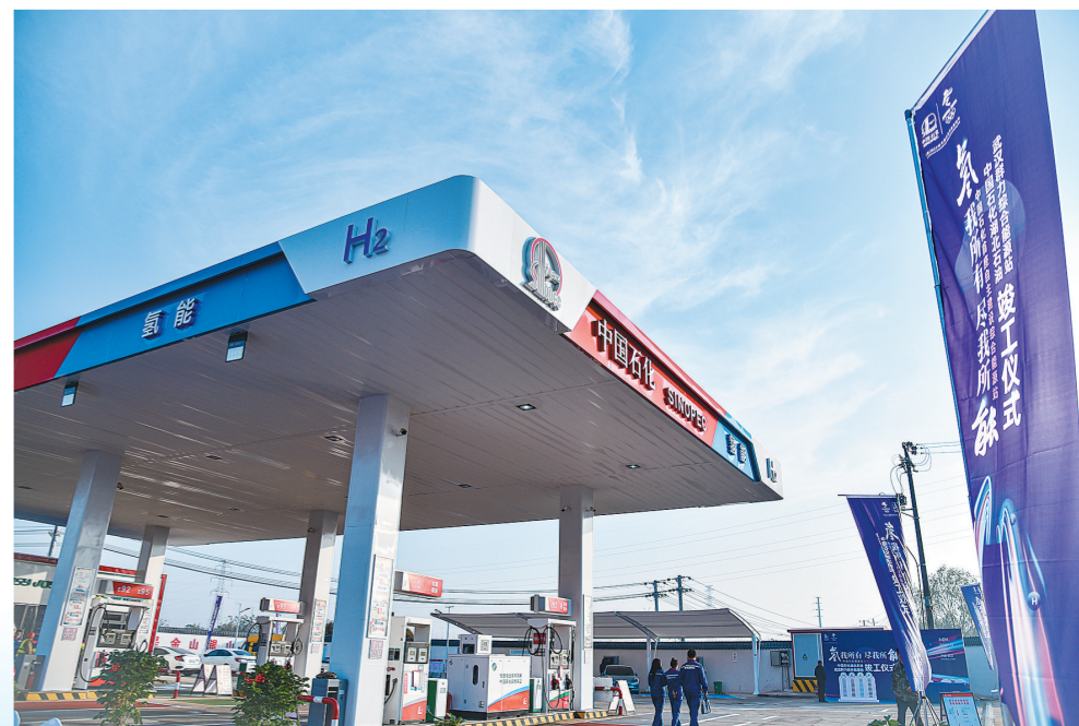
武汉群力综合加能站由石化机械提供全套加氢设备,日加氢能力500千克,可满足40余辆氢能公交车的需求,一辆车加满氢仅需4分钟。 陈艺婷摄
