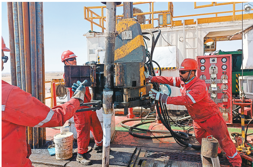
中原石油工程科威特公司SINOPEC-920队外籍员工在井口独立完成下钻操作。 崔 震 摄
