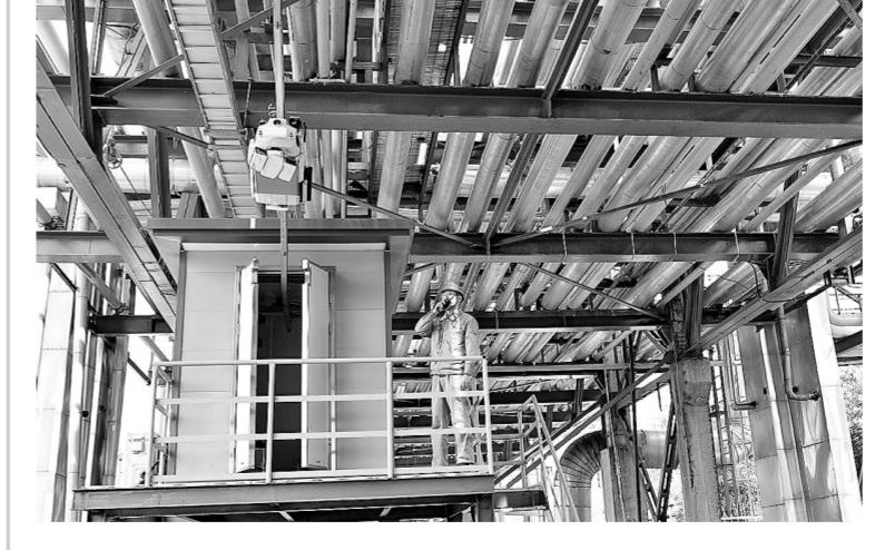
人会在第一时间抓拍画面向后台工作站报警并自主停车。外管机器人单次往返巡检时长为两小时,完成巡检后自动返回充电桩对接充电器,充好电后再次出发巡检。外管机器人工作站为人机交互平台,设立在贮运厂火炬气回收作业区中控室,由专人盯盘,对数据进行深度处理、分析、预警、存档。工作站技术人员可通过应用软件对机器人进行实时控制,实现手动、自动、跟随
